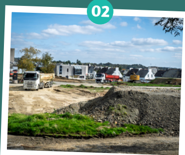
Début du chantier du futur hôpital Villeneuve à Quimperlé - janvier 2025
