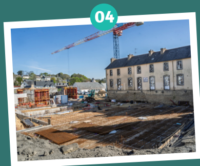
Démarrage des travaux bâtimentaires du conservatoire - avril 2025
