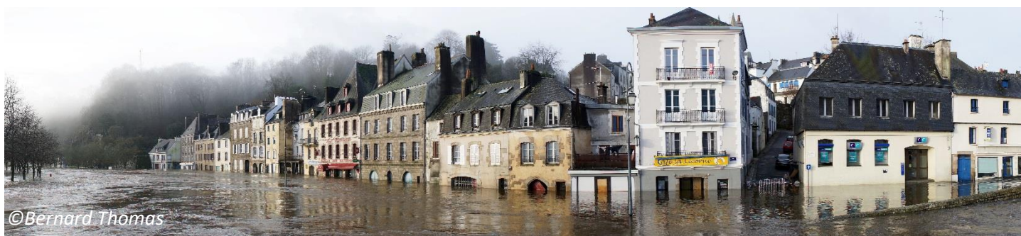
Figure 1 : la Laïta en crue à Quimperlé (décembre 2013, Source : B. Thomas)
