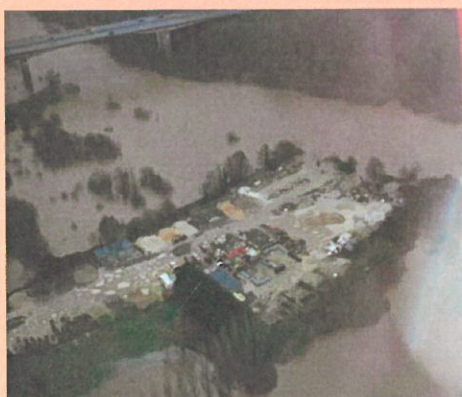
Photo : Remblais en lit majeur de la Laita, à l'aval de la RN165 (12/2000)
