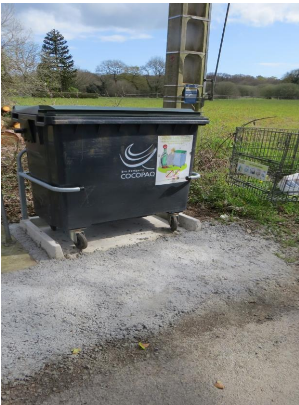
Exemple de mise en place de plateforme de maintien en bordure de route rurale avec raccord voirie en béton fibré.
