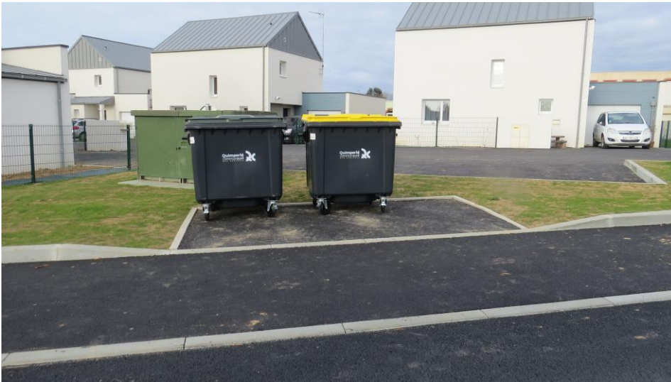
Exemple de dalle béton en bordure de route.
